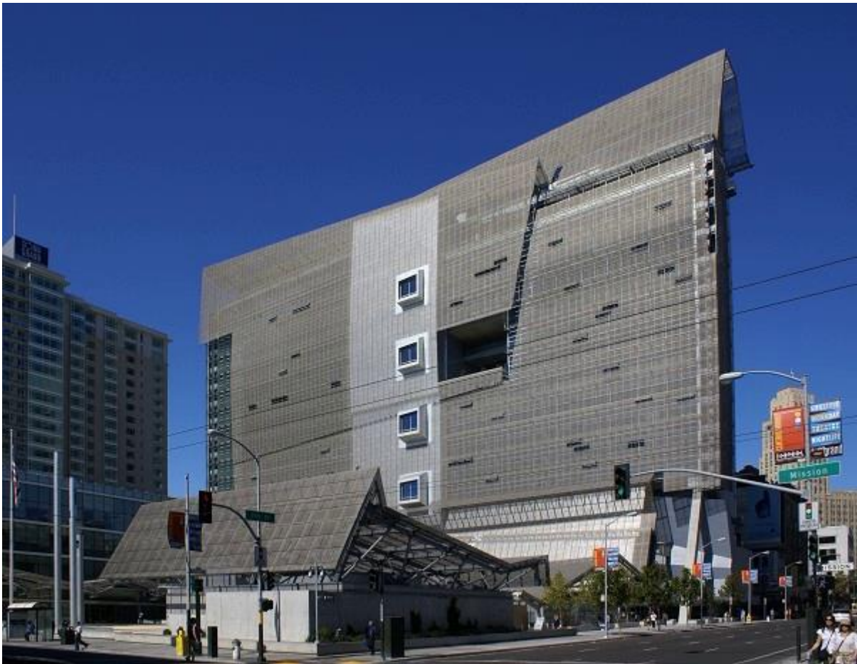
Le bâtiment fédéral de San Francisco par Thom Mayne
